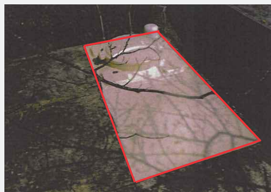
〈修理後①〉 破損箇所のみ交換。
