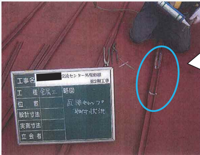
〈修理中①〉瓦状キャップ取付状況
