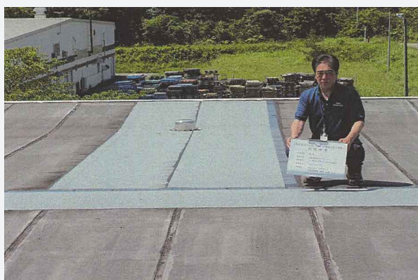
〈写真⑥〉 修理後
