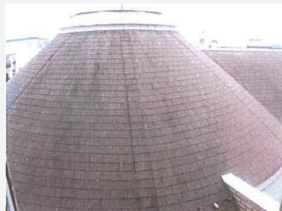
〈写真⑥〉 修理後
