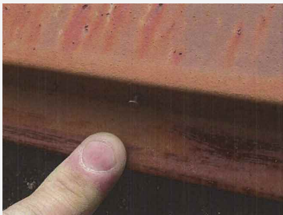
〈写真③〉 釘が浮いている
