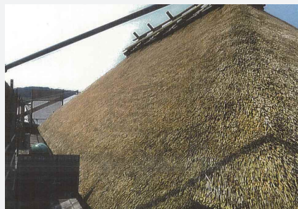
〈修理完了②〉
