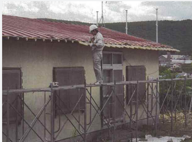
〈修理中①〉 屋根垂木組
