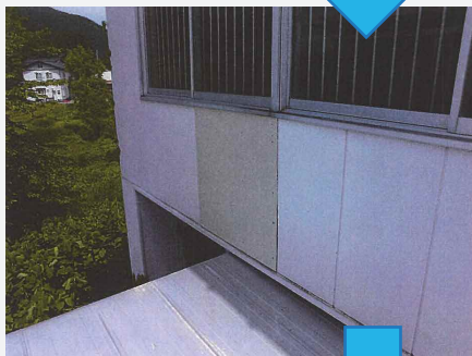
〈修理中②〉 塗装前
