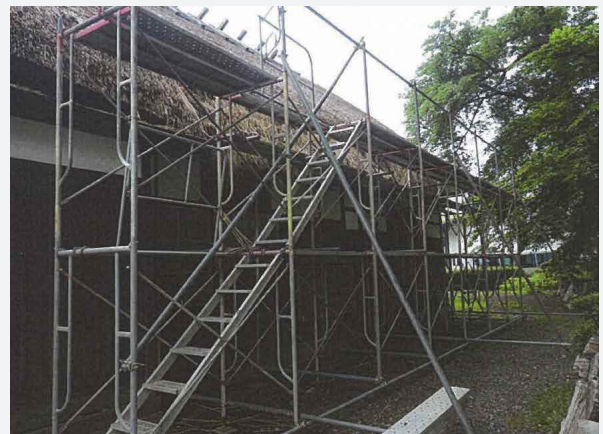
〈修理中①〉足場設置状況が確認できます。
