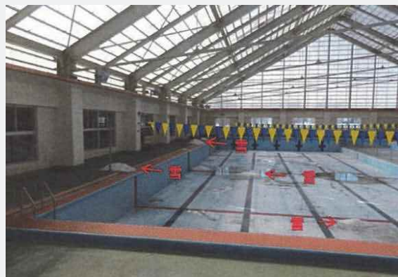
〈工事前④〉 内部に雪があることが確認できる。
