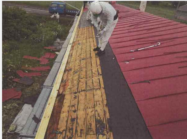
〈修理中③〉 野地板締め直し
