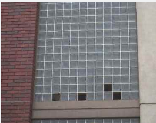
〈修理中〉 破損箇所のガラス撤去
