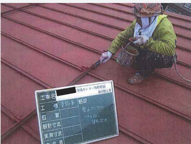
〈修理中⑤〉 雪止め塗装状況
