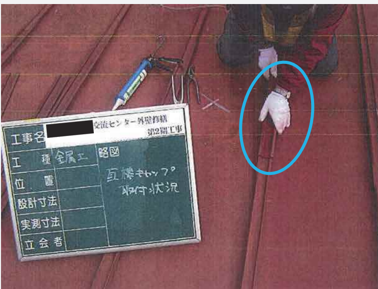
〈修理中②〉キャップはめ込み状況
