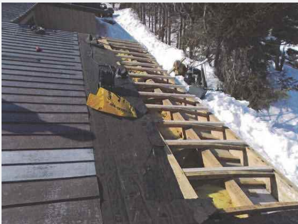
〈修理中①〉 損傷部分のみを剥がしている。
