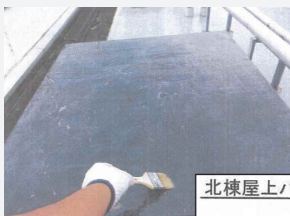
北棟屋上ハト小屋天板補修工事
