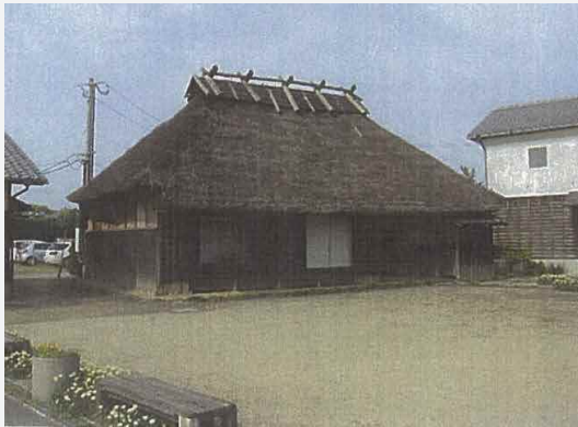
〈罹災状況①〉
