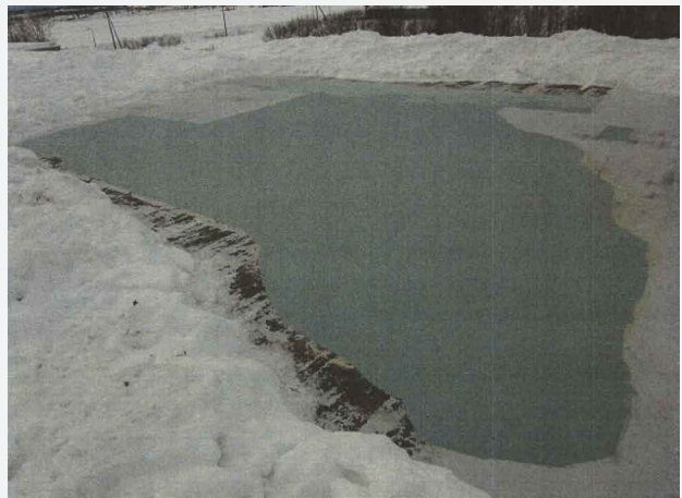
〈修理後①〉剥離範囲と修繕範囲が一致している。
