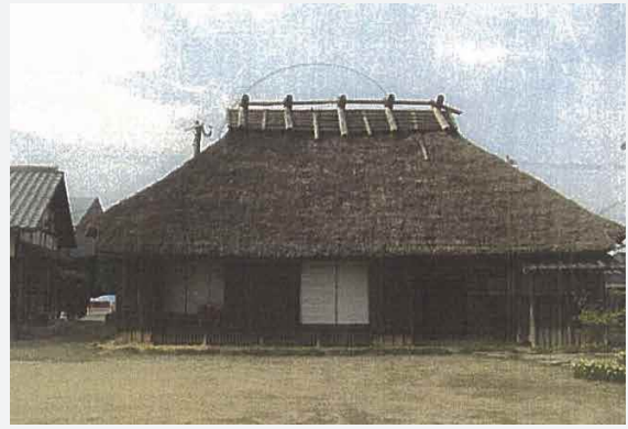
〈罹災状況②〉
