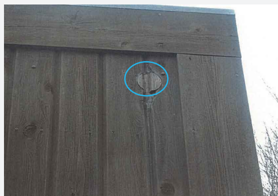
〈写真④〉 修理後
