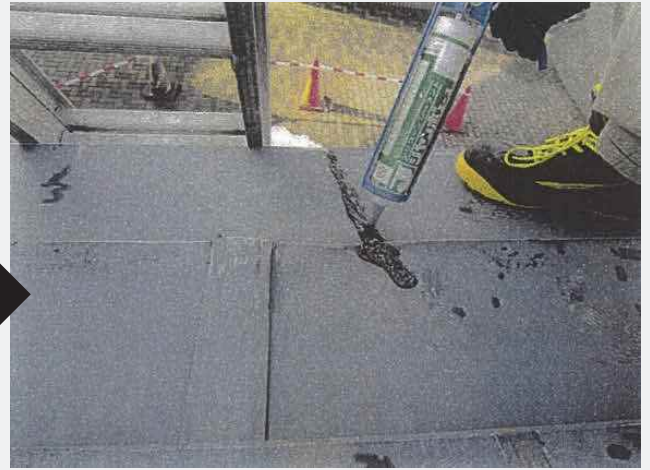
〈修理中〉コーキングで穴埋め。
