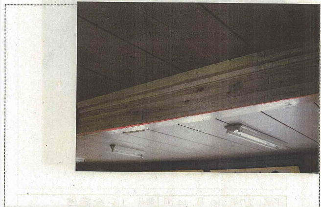
平成 28年 1月 29日 測点 2F会議室 工事概要 小屋梁交換後の状況 (室内より)
