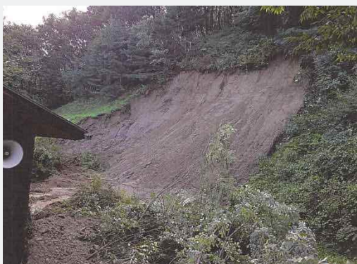
〈建物裏の土砂崩れ〉
