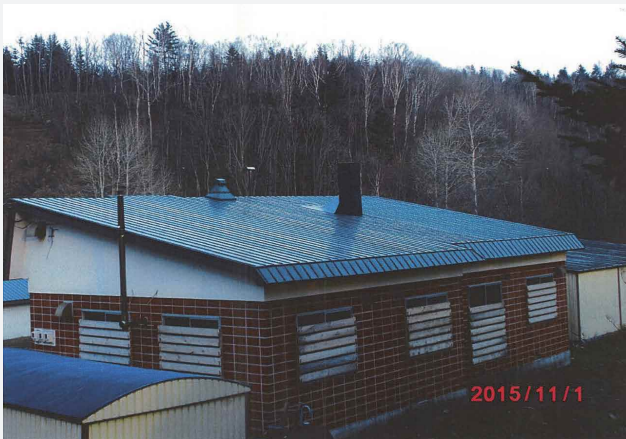
〈修理後（全体）①〉
