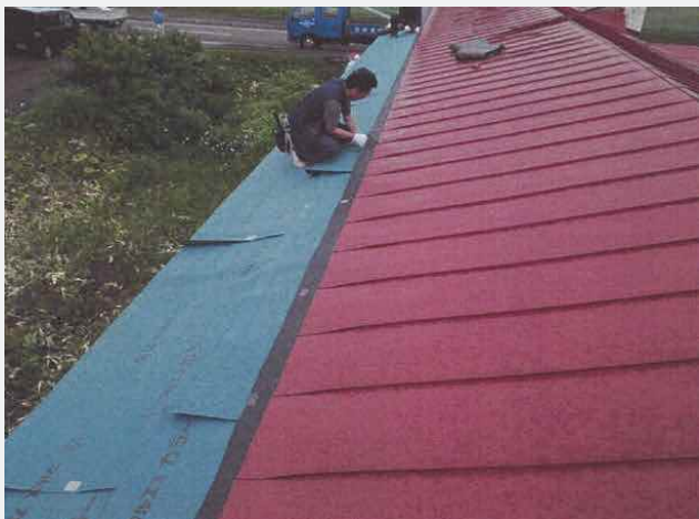
〈修理中④〉 ルーフィング貼り
