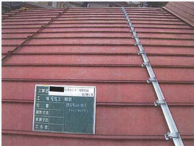
〈修理中④〉 雪止め復旧完了
