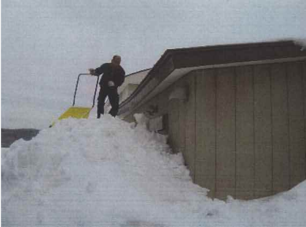
〈罹災状況①〉 雪害であることが確認できる
