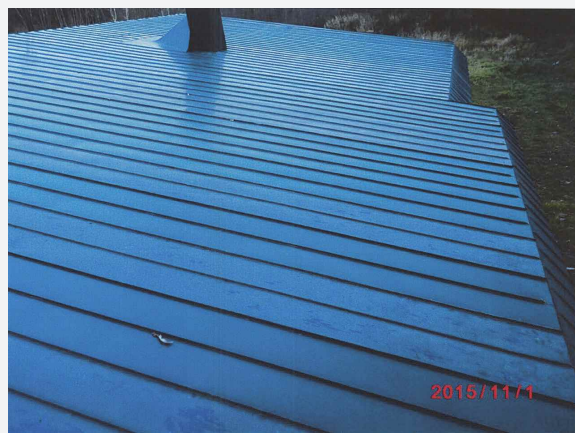
〈修理後（全体）②〉
