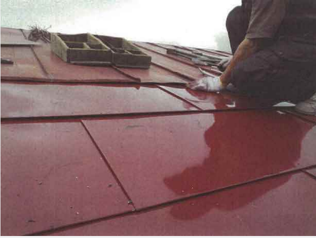
〈修理中⑥〉 修繕納め
