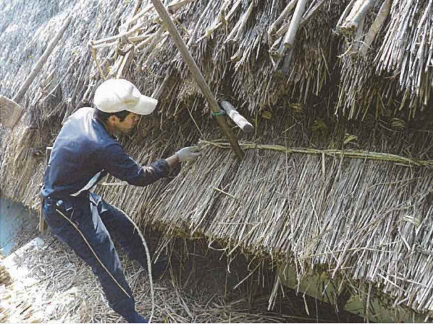
〈修理中②〉 さし茅状況
