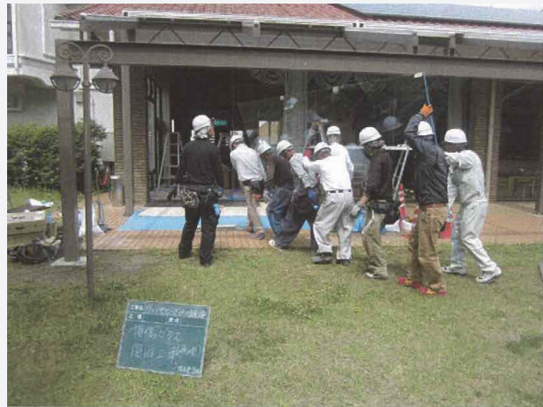
〈修理中②〉作業の様子が確認できる。
