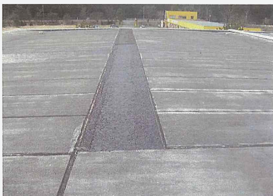
〈写真③〉 修理前
