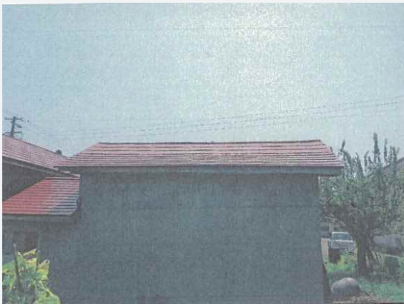
〈修理前②〉 北面
