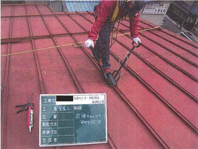
〈修理中③〉 キャップかしめ状況
