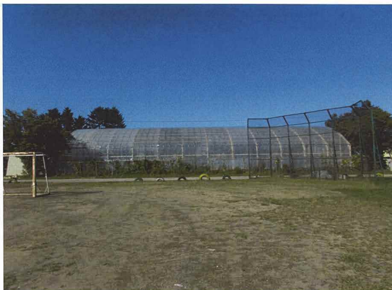
NO. 1 破損前状況 (全景)
