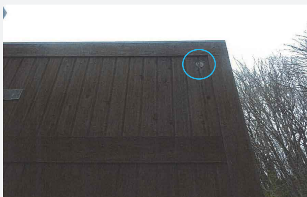
〈写真③〉 修理後
