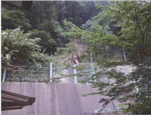
▲裏山の土砂はフェンスで抑えられている。
