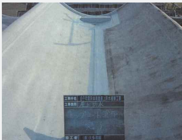
〈修理後①〉左側が修復箇所
