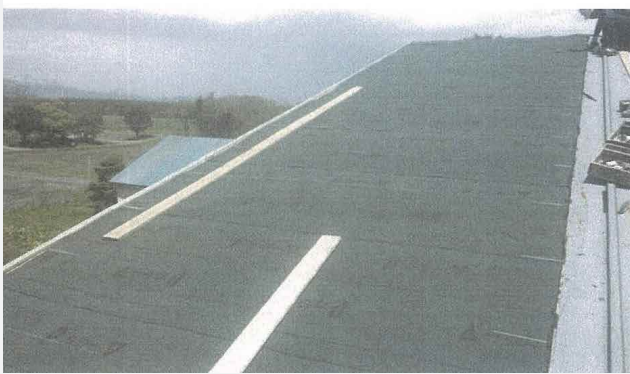
〈修理中〉 剥がれた部分のみのはり替え。
