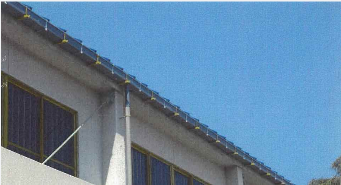
〈修理後〉白い取付金具が増えている。
