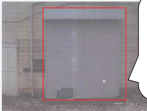
〈修理後〉扉がシャッターになっている。
