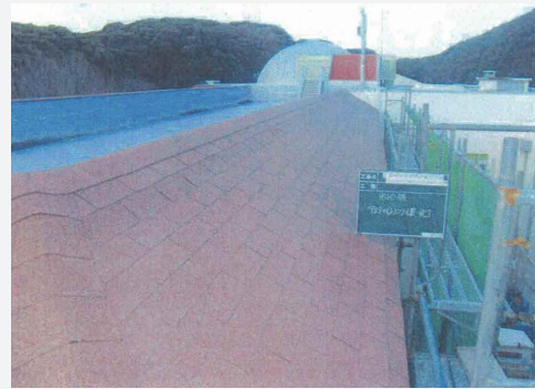
〈修理完了②〉
