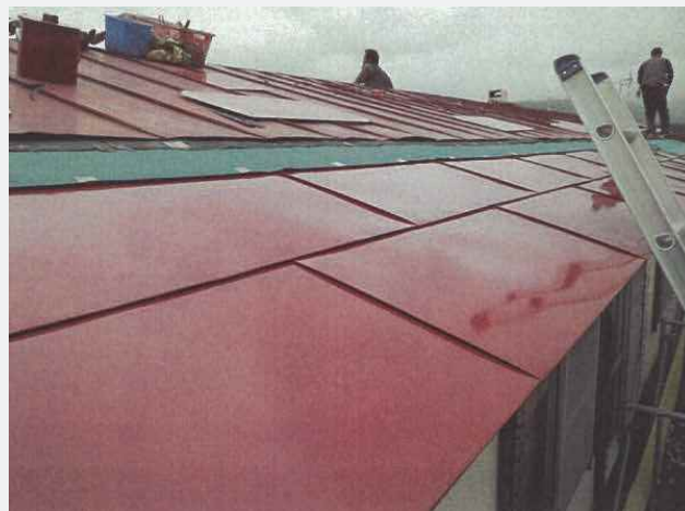
〈修理中⑤〉 四つ切り板金葺き
