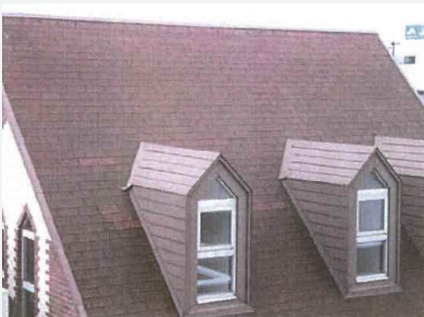
〈写真③〉 修理後
