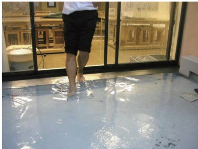
〈溢水を証明する資料の例〉バルコニーに樋の排水量を上回る雨水が溜まり、サッシの隙間から、室内に流入したことが分かる。
