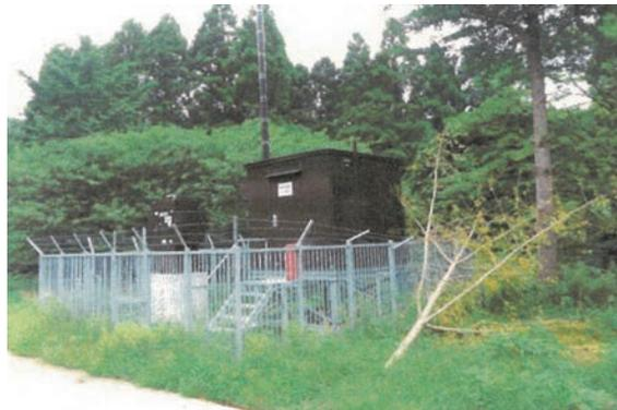
※損害自体は、倒木によるフェンスの破損
