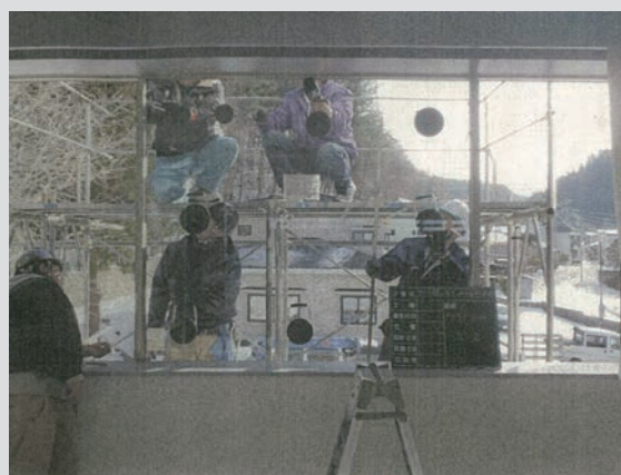
〈修理中②〉作業員の人数が確認できる
