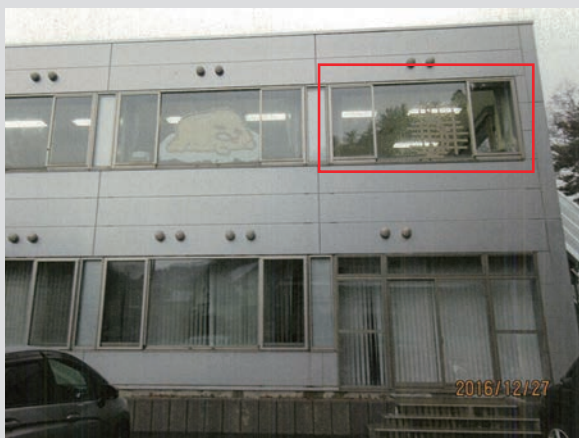
〈修理前①〉外側から
