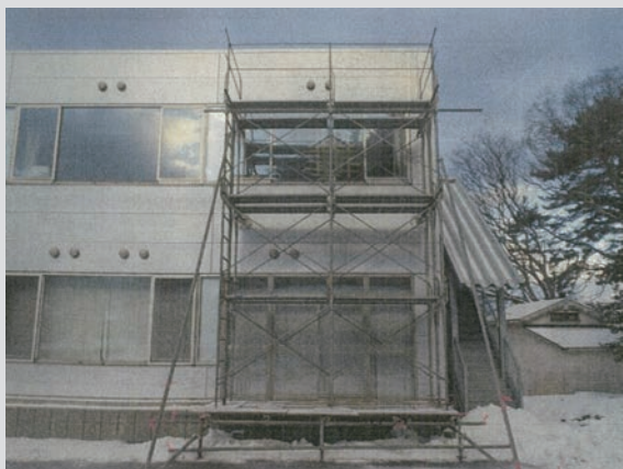
〈修理中①〉外側から。足場を確認出来る
