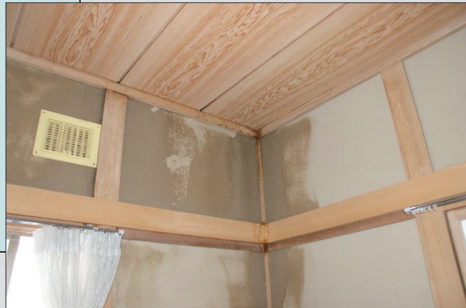
〈実際のすが漏れの様子〉
