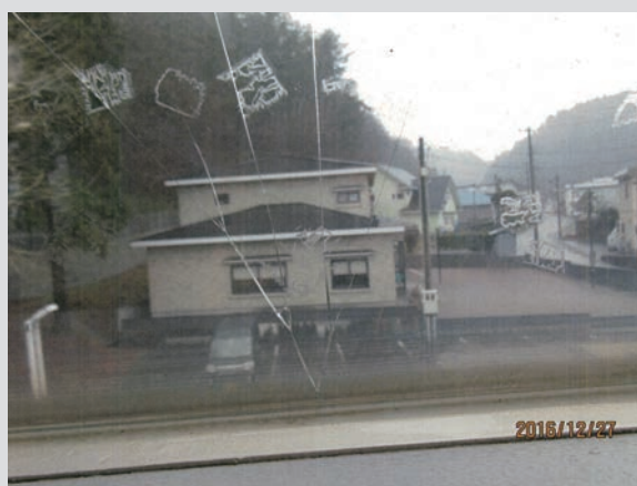
〈修理前②〉内側から
